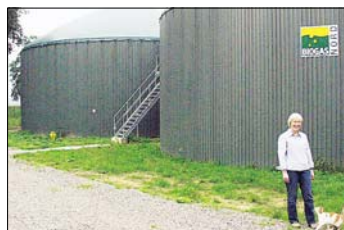
Fortschrittlich: Ortsvorsteherin Anneliese Schulte-Döinghaus vor ihrer neuen Biogas-Anlage.
