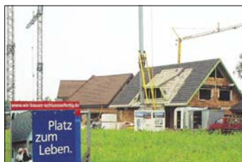
Platz zum Leben: Zurzeit wird mitten im Klosterdorf ein neues Baugebiet erschlossen.
