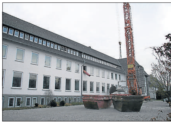
Am Westflügel haben die Arbeiten schon begonnen. Danach ist der Ostflügel an der Reihe.
