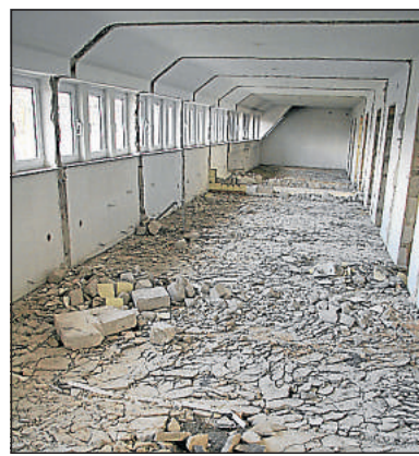
Wo sonst Schwesternzimmer waren, wird alles entkernt.
