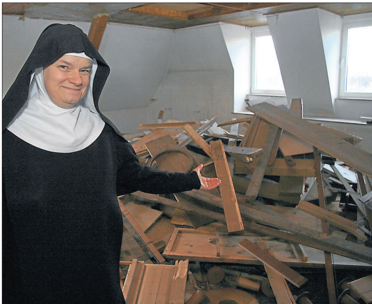
Trümmer und Schutt bestimmen derzeit das Bild im Westflügel des Varenseller Klosters. Bis Herbst 2013 sollen die Arbeiten in diesem Gebäudeteil abgeschlossen sein. Dann geht es im Ostflügel weiter. Schwester Teresa Friese berichtet als Webmasterin auf der Website des Klosters jeweils über den aktuellen Stand der Renovierung. Bilder: Tiemann (4)
