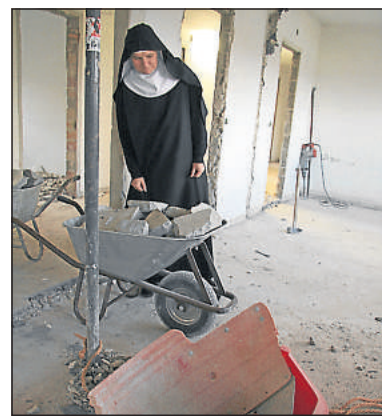
Alle Zimmer werden komplett renoviert.
