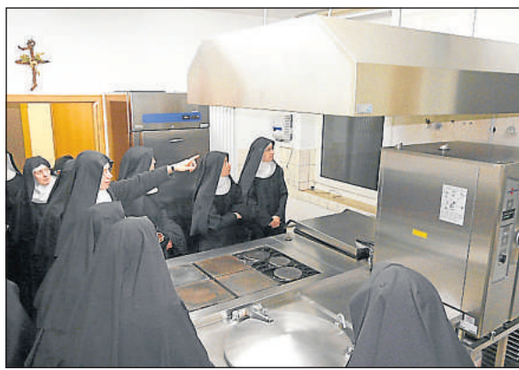
Eine provisorische Küche ist für die Dauer der Sanierung extra eingerichtet worden. Bild: Kloster
